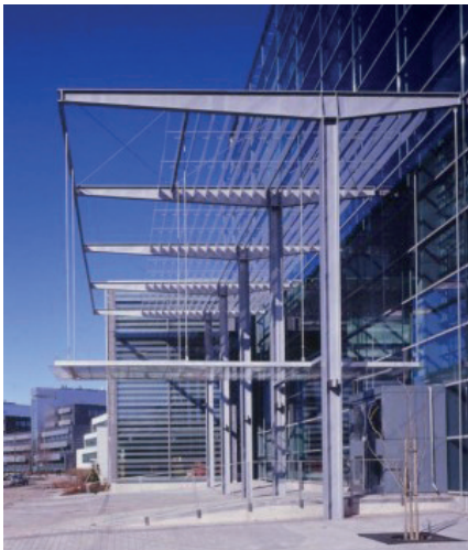
Helsingin yliopiston Biokeskus 3:n ikkunakalvoiksi valittiin nano-teknologiaa hyödyntävä 3M Prestige -auringonsuojakalvo, joka ei muuta rakennuksen ilmettä, mutta alentaa merkittävästi lämpökuormaa.
