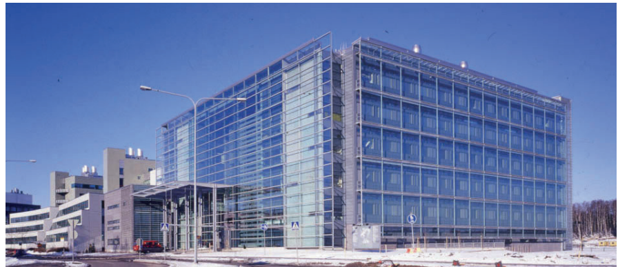
Helsingin yliopiston Biokeskus 3:n ikkunakalvoiksi valittiin nano-teknologiaa hyödyntävä 3M Prestige -auringonsuojakalvo, joka ei muuta rakennuksen ilmettä, mutta alentaa merkittävästi lämpökuormaa.
